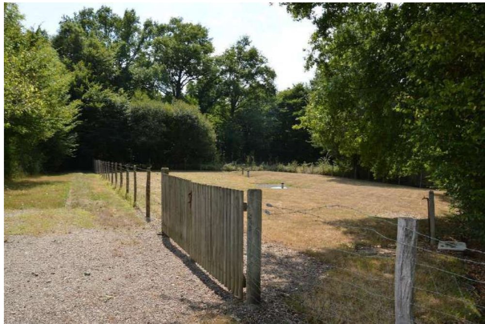
Photographie 9 : Station d'épuration (Source : ENCIS Environnement)
