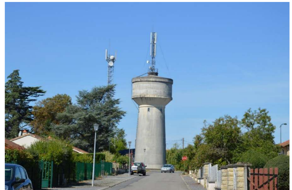
Photographie 11 : Station radioélectrique de Bussière-Poitevine (Source : ENCIS Environnement)
