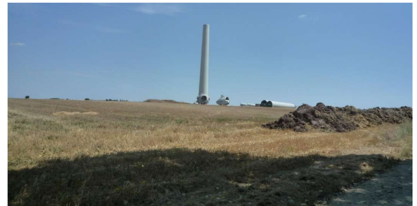
Photographie 31 : Exemple de stockage de terre durant un chantier éolien (Source : ENCIS Environnement)
