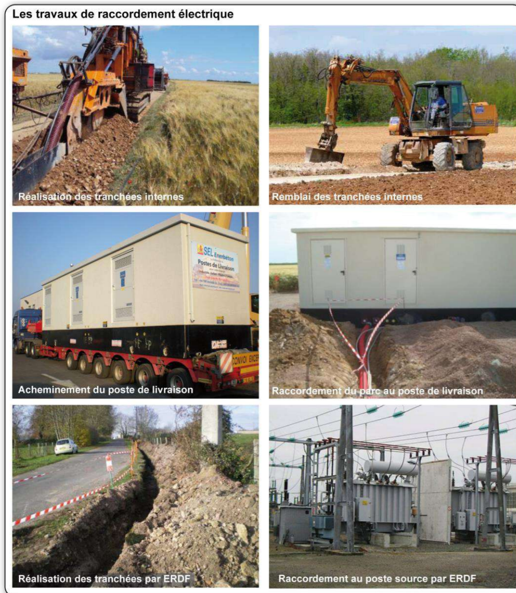
Photographie 27 : Travaux de raccordement électrique
