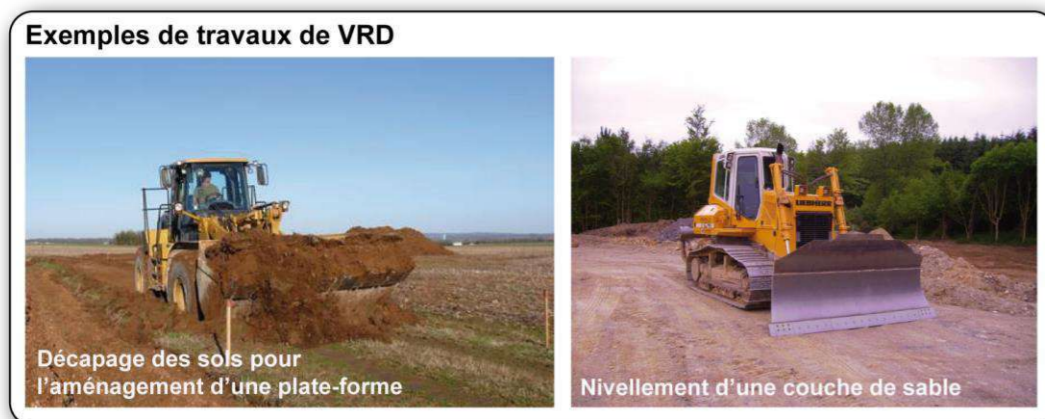
Photographie 25 : Exemples d'engins de travaux de VRD
