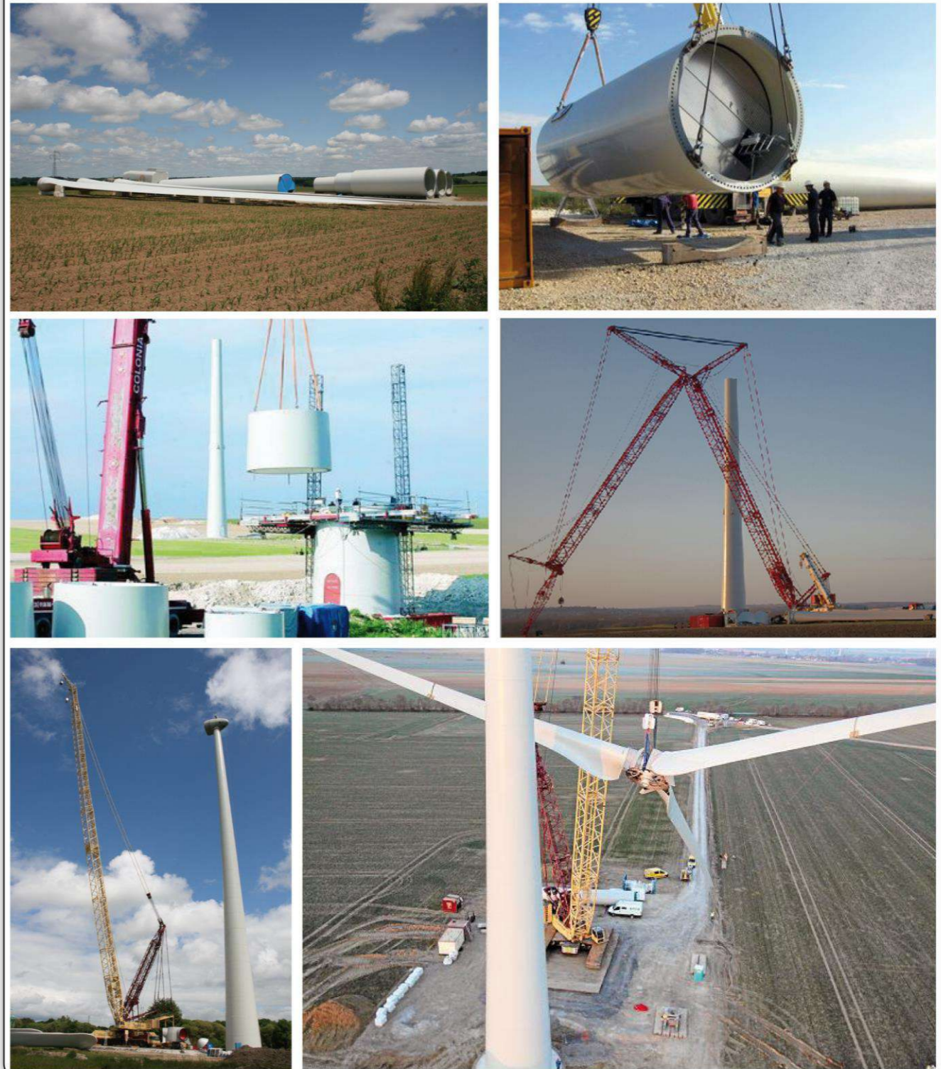
Montage d'une éolienne
