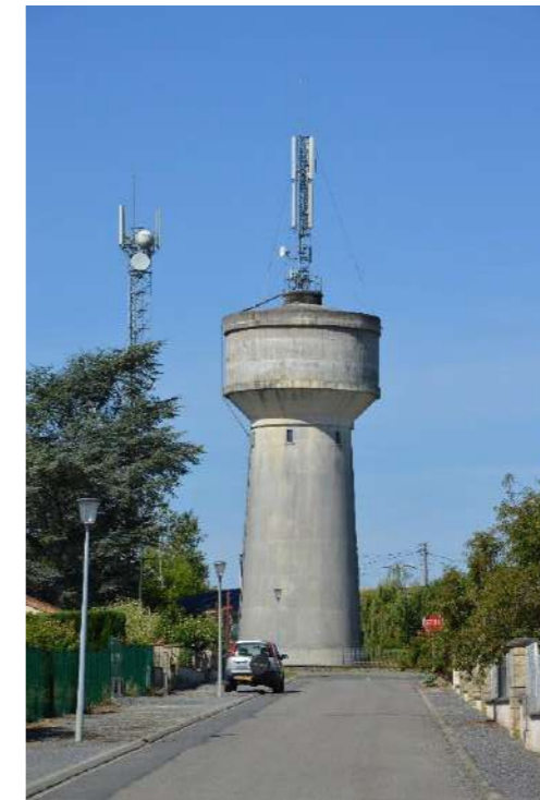
Photographie 10 : Station radioélectrique de Bussière-Poitevine (Source : ENCIS Environnement)
