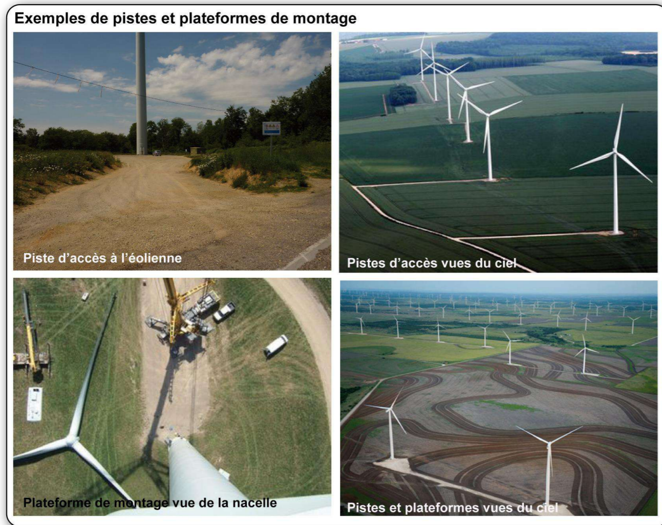
Photographie 23 : Exemples de plateformes de montage et de pistes (Source : ENCIS Environnement)
