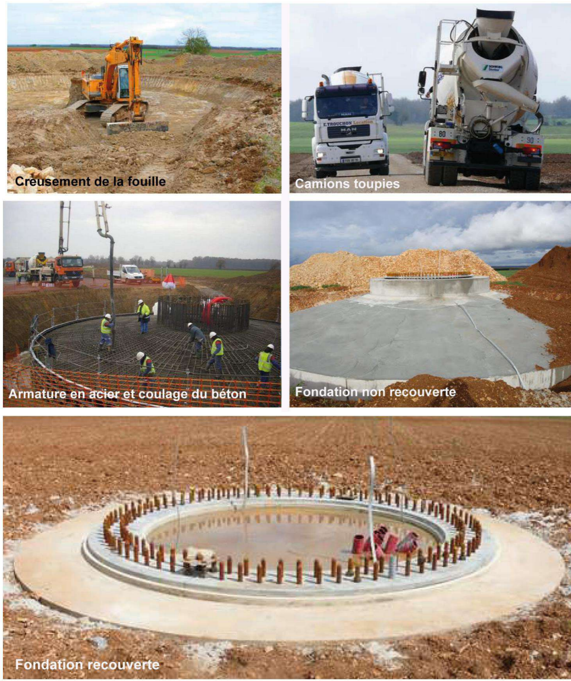
Photographie 26 : Etapes de réalisation d'une fondation d'éolienne
