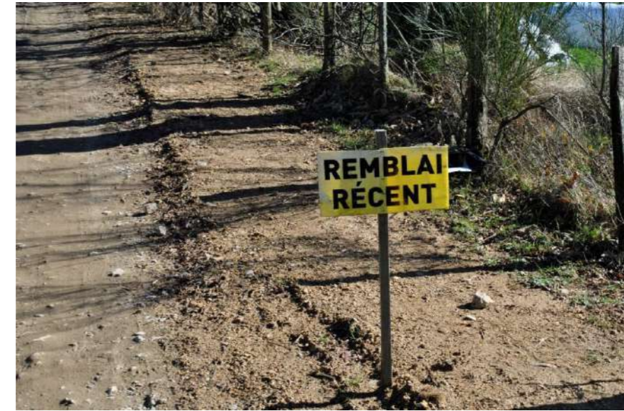
Photographie 32 : Exemple de remblai des tranchées électriques le long d'une piste (Source : ENCIS Environnement)
